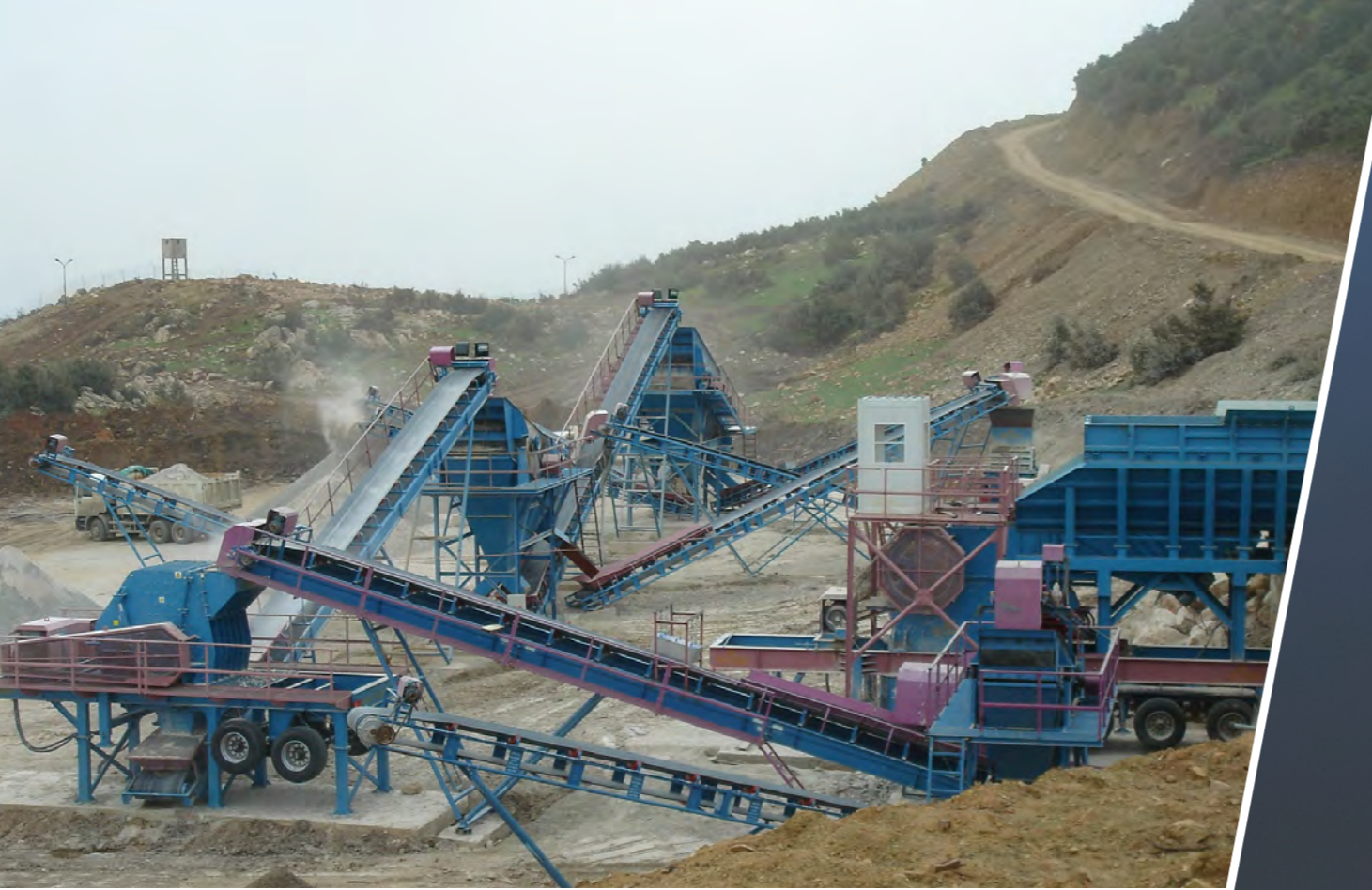
Дробильная установка в Алжире, город Тисимсилът
