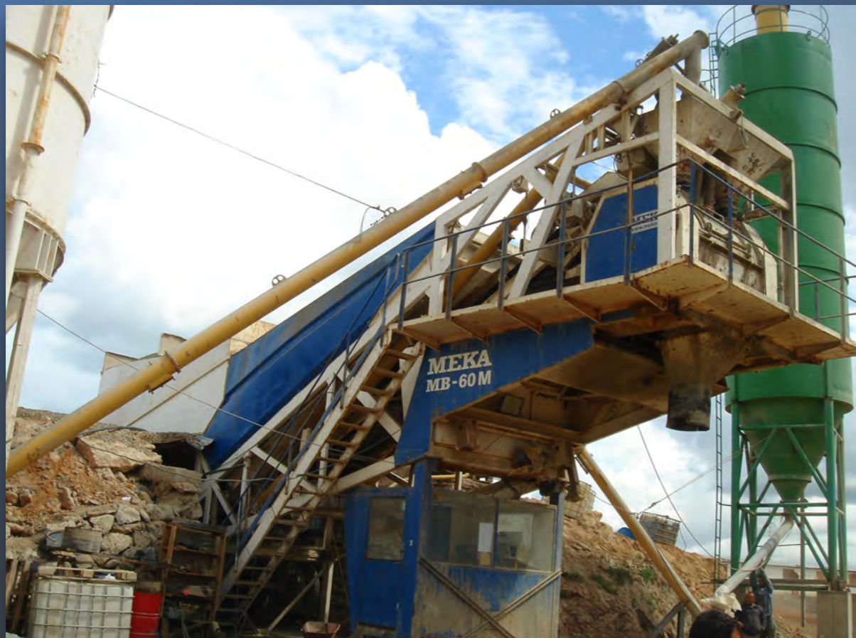
Бетонный Завод - Город Алжир/ В Алжире
