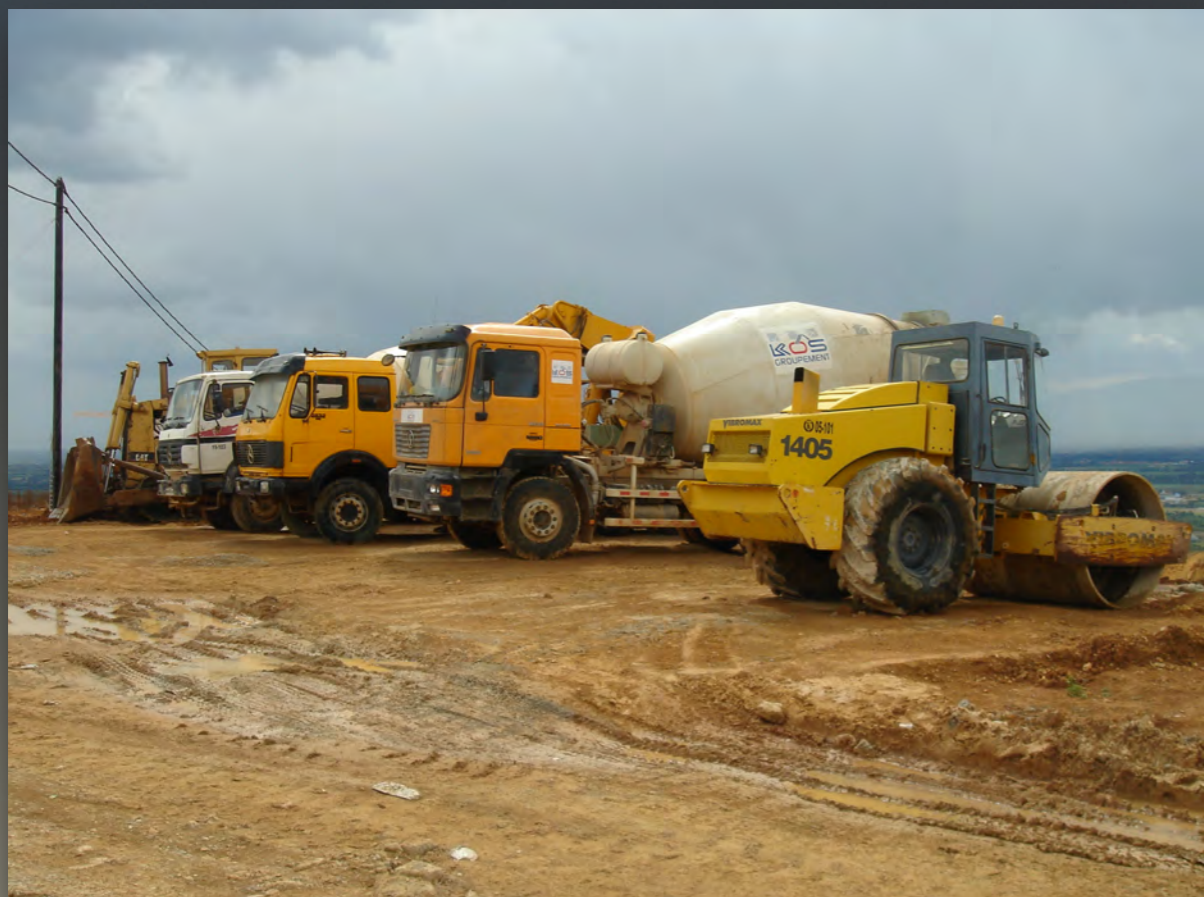
Бетонный Завод - Город Алжир/ В Алжире
