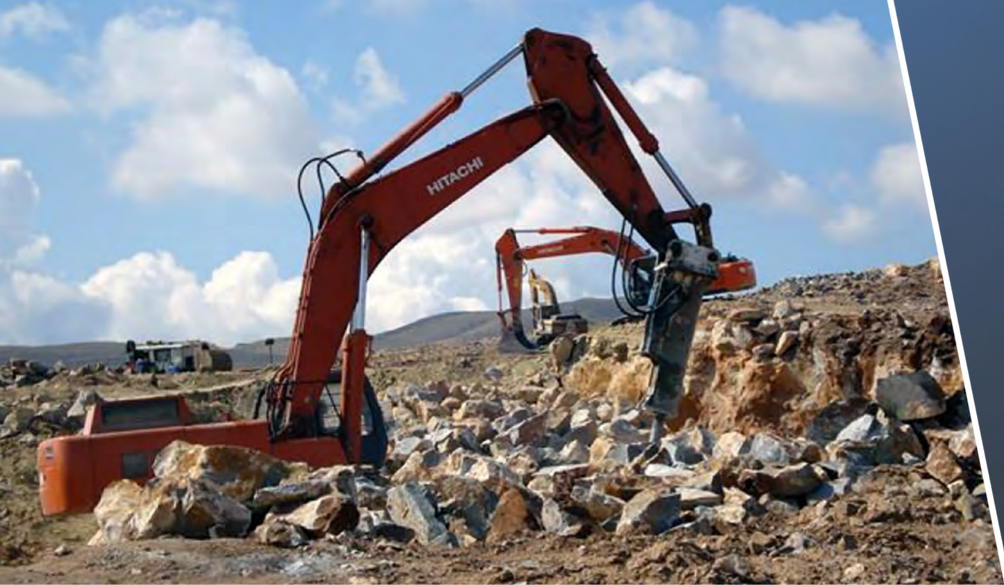
Поставка раздробленного камня Японскому консорциуму СОJААL для строительства автотрассы в Алжире, город Аин Саид-Тарф
